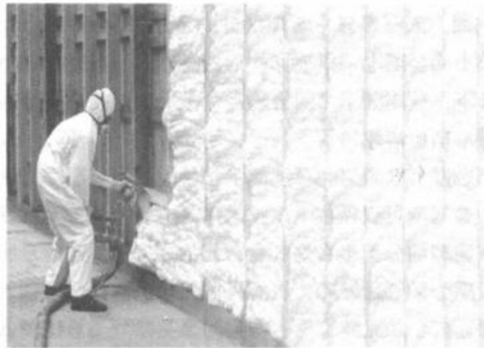
一位操作者正在利用聚氨酯泡沫对建筑物进行隔热处理
